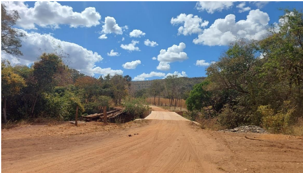
Figura 4: Pontes de acesso à região. À esquerda ponte de madeira em condições precárias, à direita nova ponte em concreto.
